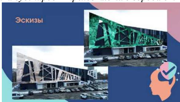
Рисунок 112. Проект мэппинга на здание мультимедийного парка «Россия – Моя история от команды «FAT VORONA»
